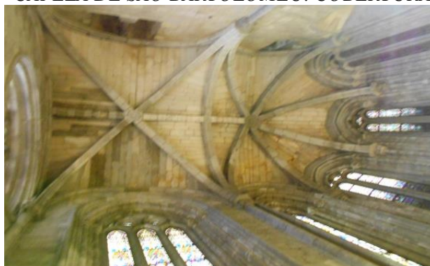
FIGURA 2 – CAPELA DE SÃO BARTOLOMEU. COBERTURA E JANELAS
